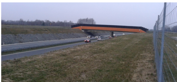
Rys. 6.10. Przejście zespolone w Jodłówce koło Brzeska (465 km) – widok ogólny
