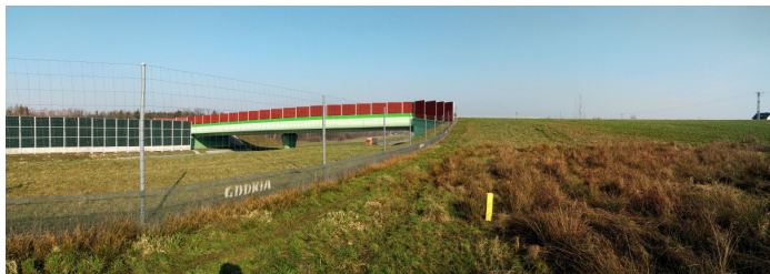
Rys. 6.12. Przejście zespolone w Sterkowcu koło Brzeska – widok ogólny
