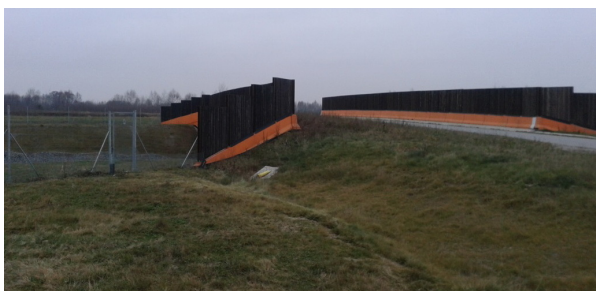
Rys. 6.9. Przejście zespolone w Jodłówce koło Brzeska (465 km) – widok na przejście
