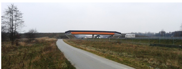
Rys. 6.8. Przejście zespolone w Jodłówce koło Brzeska (464 km) – widok ogólny
