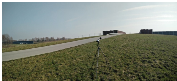
Rys. 6.11. Przejście zespolone w Sterkowcu koło Brzeska – widok na przejście. Z lewej strony widoczny fragment autostrady A4.
