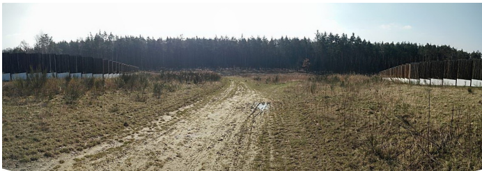
Rys. 6.3. Most krajobrazowy w Jasieniu koło Brzeska – widok na przejście
