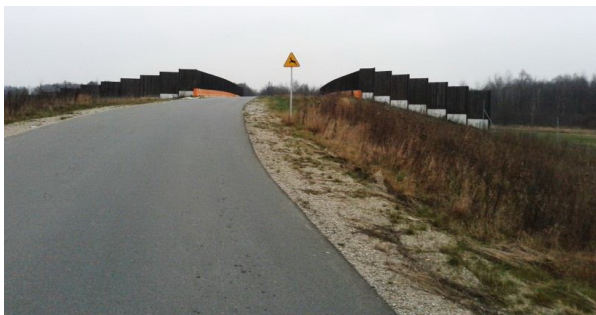
Rys. 6.7. Przejście zespolone w Jodłówce koło Brzeska (464 km) – widok ogólny
