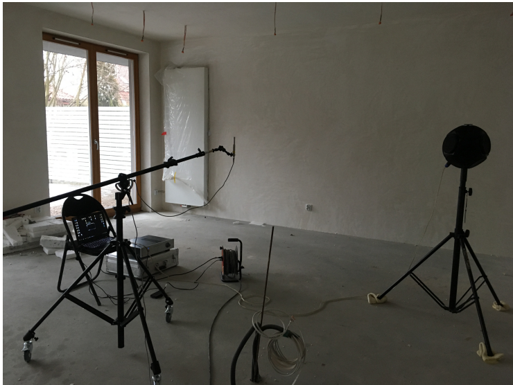
Rysunek 1. Zdjęcie wyposażenia pomiarowego w wybranym pomieszczeniu nadawczym
